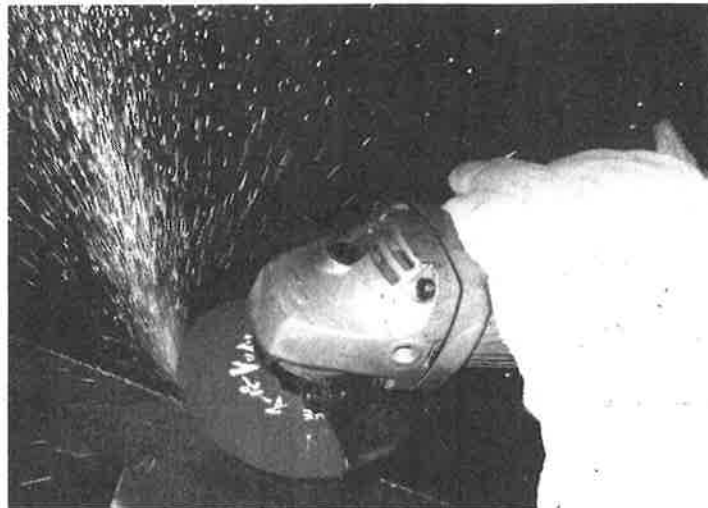
スーパーレードによる研磨作業
